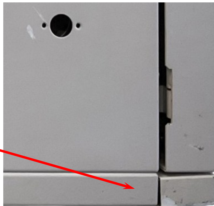
【塗装剥げ補修部例】
